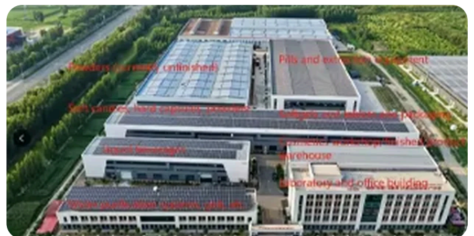
Panoramica dello stabilimento produttivo
